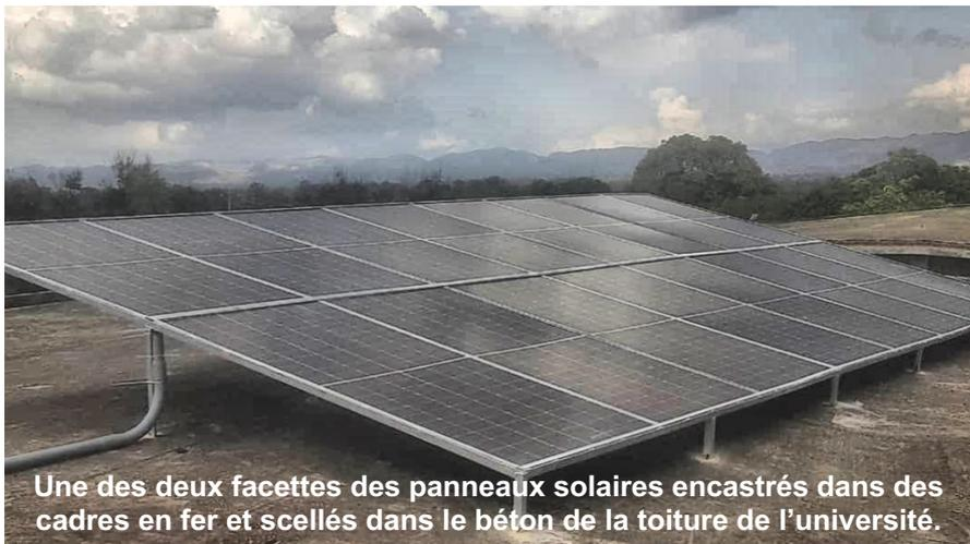
Une des deux facettes des panneaux solaires encastrés dans des cadres en fer et scellés dans le béton de la toiture de l'université.
