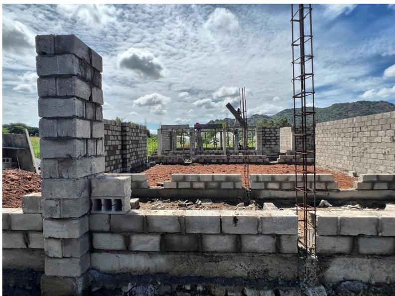
**Les fondations** ont requis de grandes quantités de pierres (jusqu'à une profondeur de 60 cm sur des fondations de 80 cm), compte tenu du sol argileux du terrain agricole.
